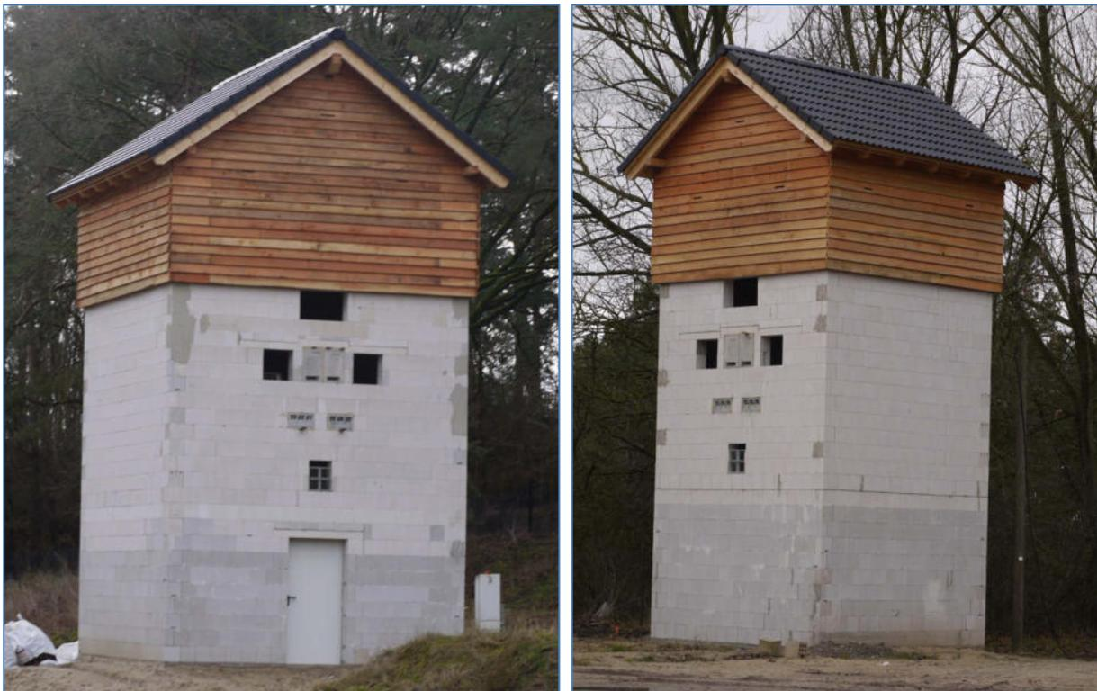
**Abb. 12 und 13** Beispiel eines Artenschutzturmes (im Rohbau) mit Verschalungen als Fledermausspaltenquartier.
