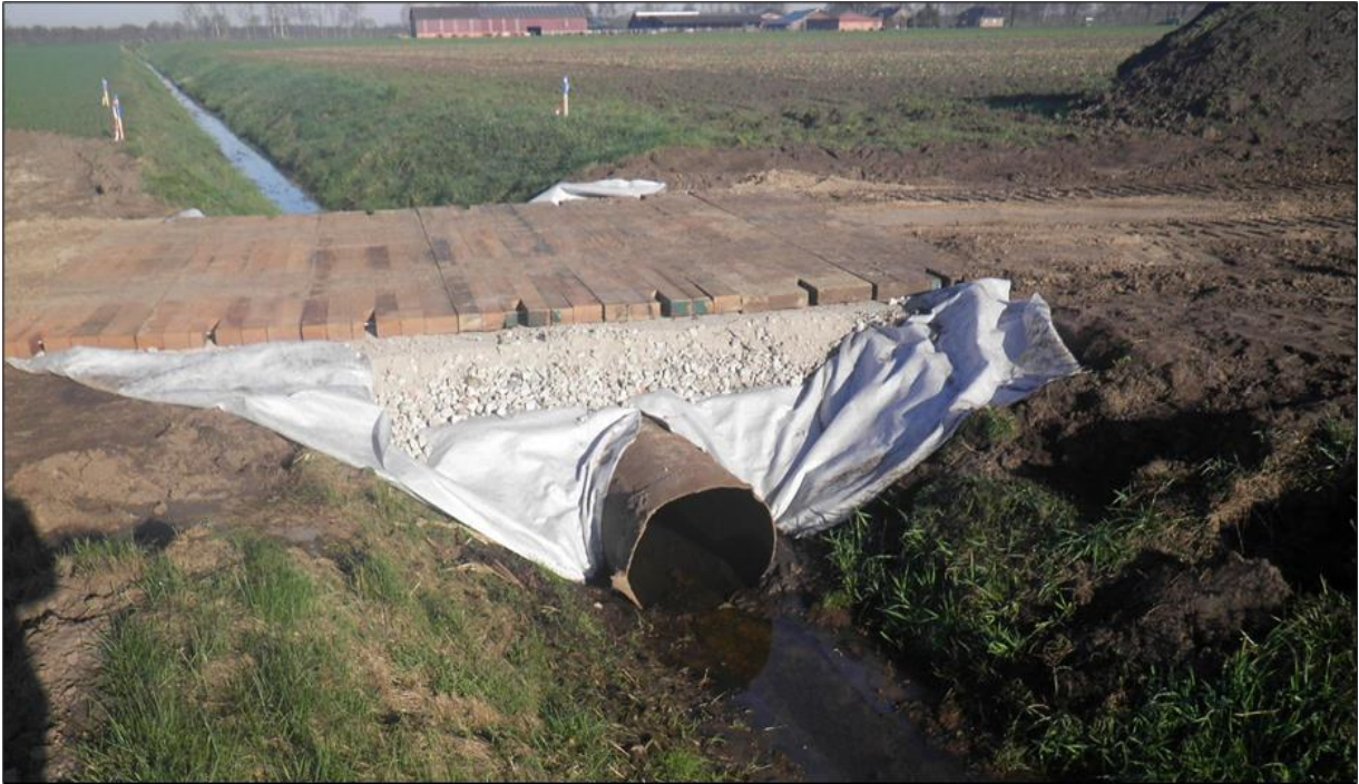
Abbildung 2: Beispiel einer Gewässerüberfahrt mit temporärem Rohrdurchlass
