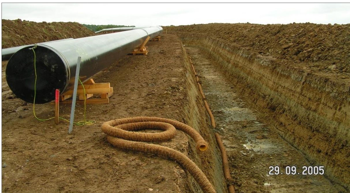
Abbildung 6: Beispiel offener Rohrgraben
