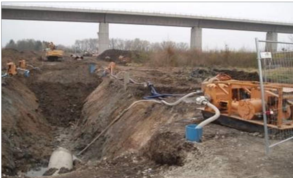
Abbildung 8: Beispiel Bauwasserhaltung
