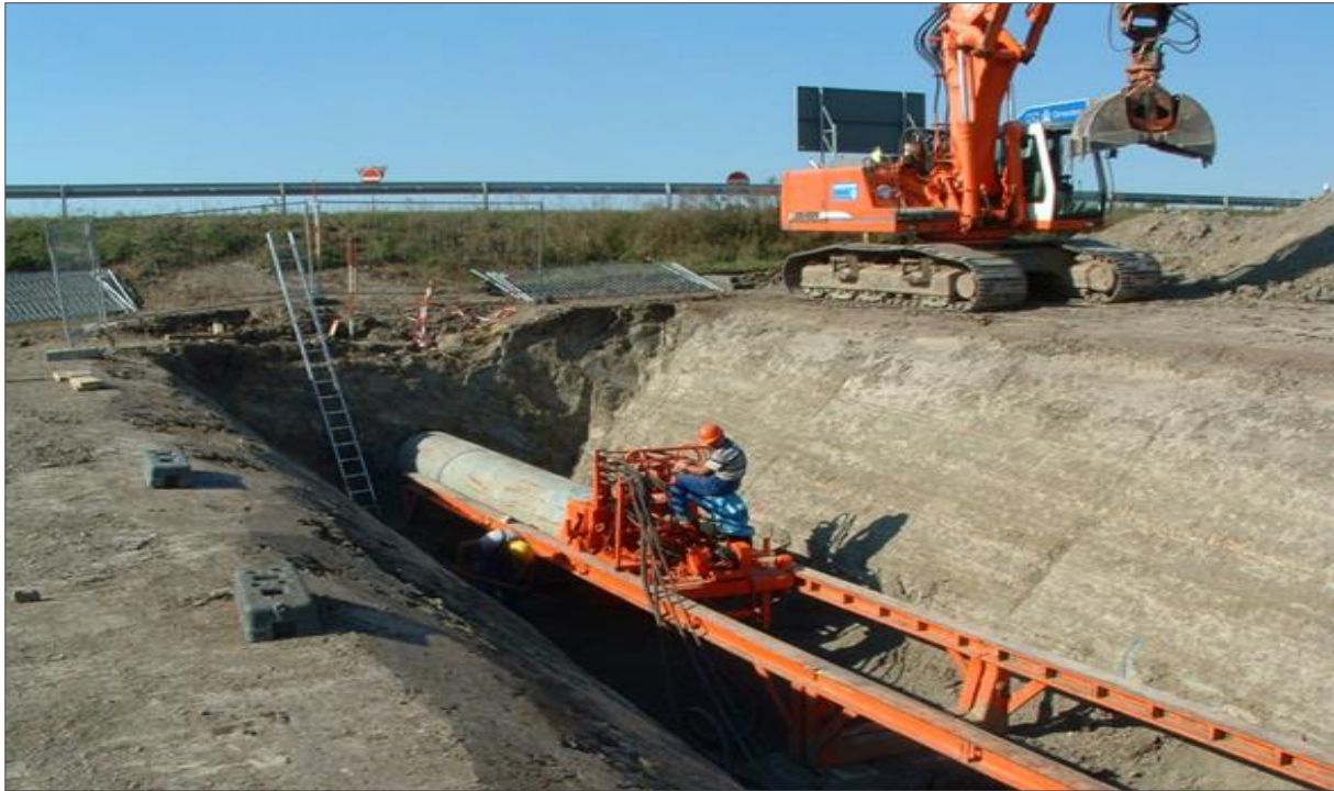
Abbildung 7: Beispiel der Unterpressung einer Straße
