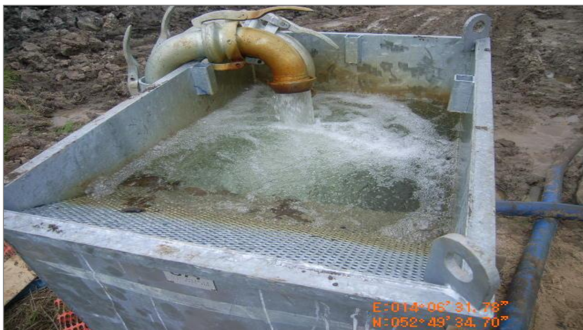
Abbildung 5: Beispiel eines Klär- und Absetzbeckens
