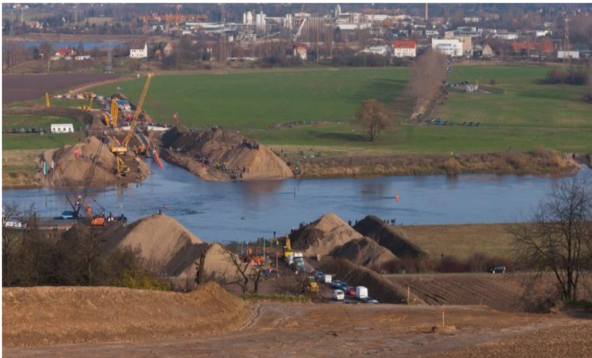
Abbildung 1: Beispiel einer offenen Querung von Gewässern mittels Düker
