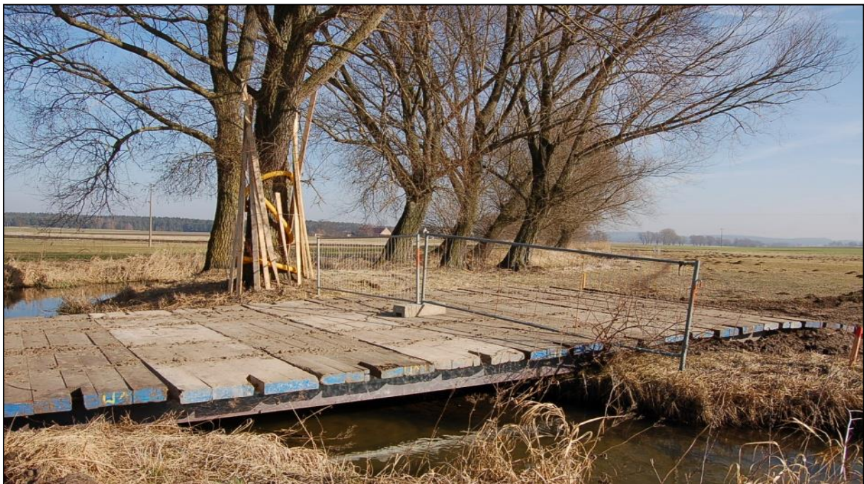
Abbildung 3: Beispiel einer Gewässerüberfahrt mittels Pionierbrücke
