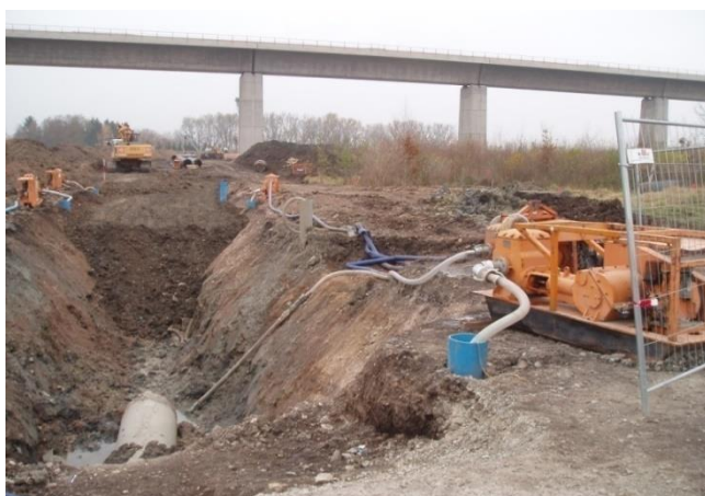
Abbildung 14: Wasserhaltungsmaßnahmen
