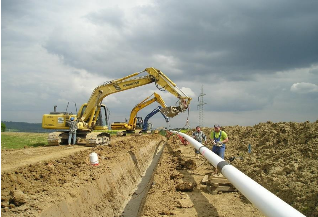
Abbildung 16: Absenken des Rohrstranges
