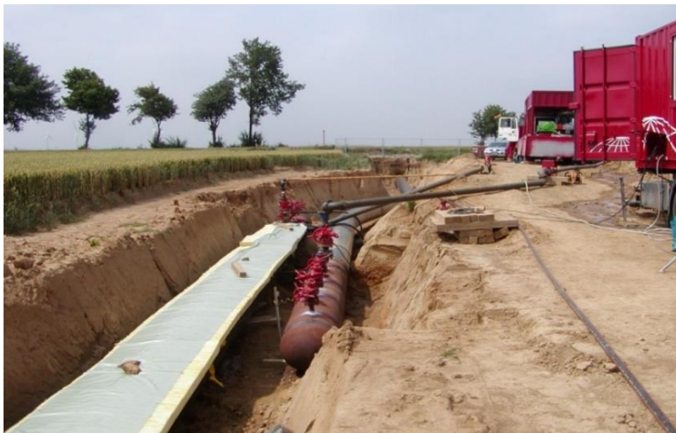
Abbildung 22: Wasserdruckprüfung
