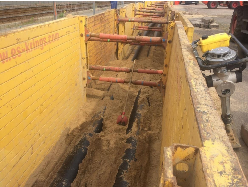
Abbildung 21: Einsandung und Verdichtung des Rohrgrabens in der Straße
