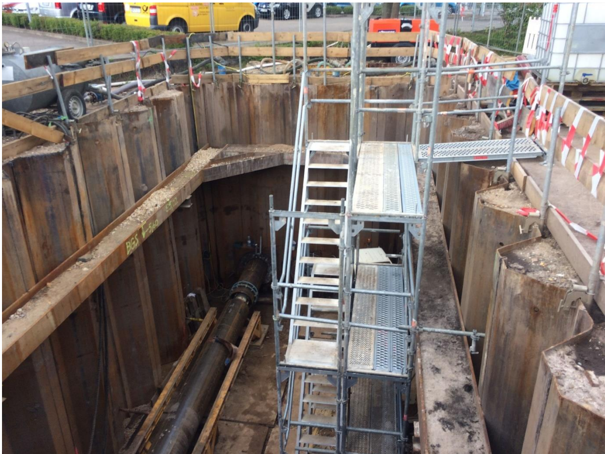
Abbildung 19: Anschweißen der Pressrohre
