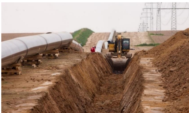
Abbildung 15: Aushebung des Grabens
