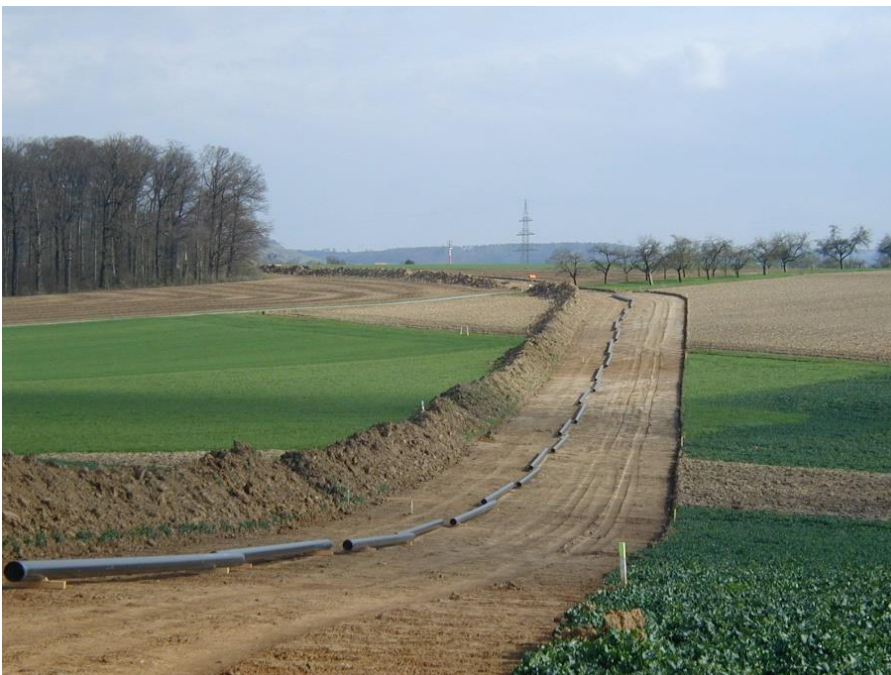
Abbildung 11: Ausfahren der Rohre
