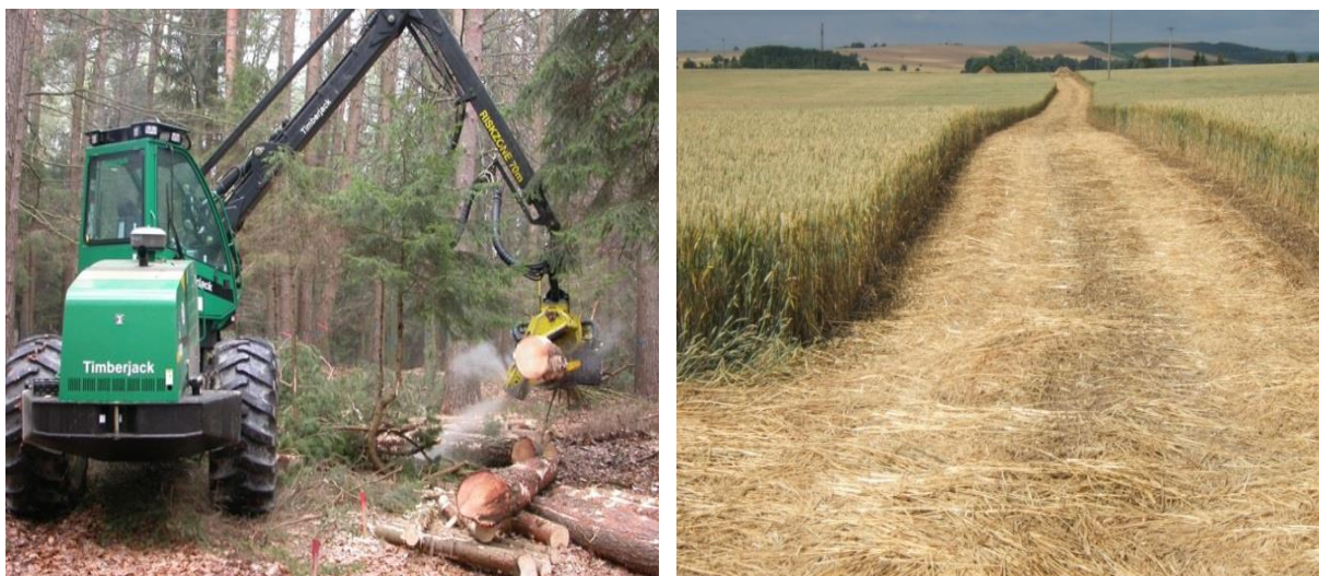
Abbildung 8: Räumen der Trasse (a+b)
