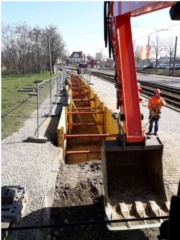
Abbildung 17: Tiefbau für Rohrtrasse in der Straße
