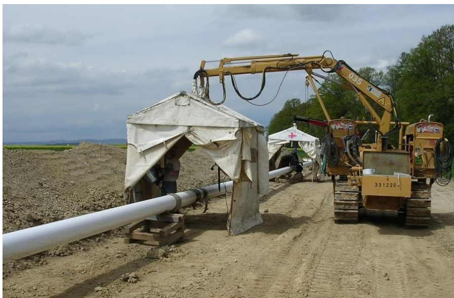
Abbildung 12: Vorstrecken der Rohre
