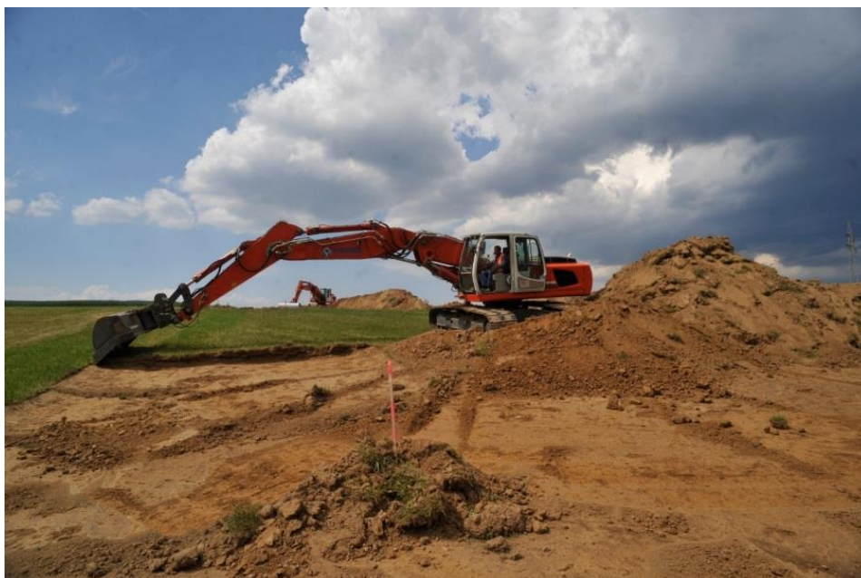
Abbildung 9: Abtragen des Oberbodens
