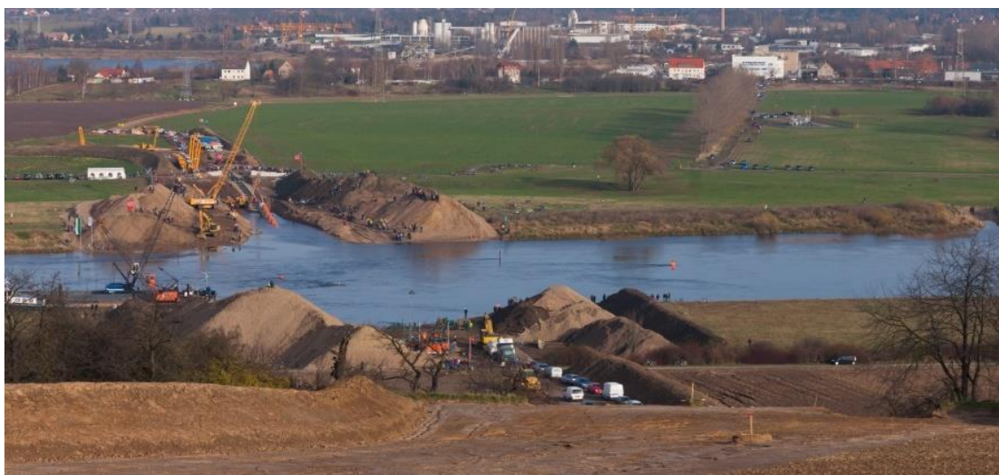
Abbildung 13: Beispiel einer offenen Querung eines Gewässers mittels Dücker
