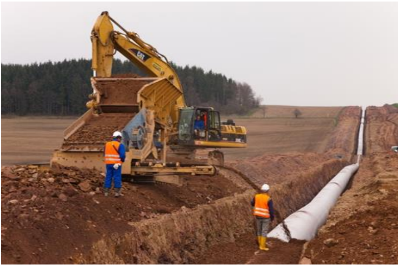
Abbildung 20: Verfüllung des Rohrgrabens
