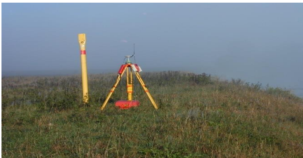
Abbildung 7: Absteckung der Trasse
