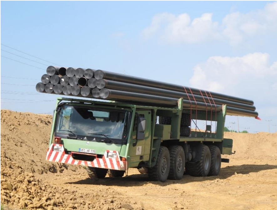
Abbildung 10: Ausfahren der Rohre
