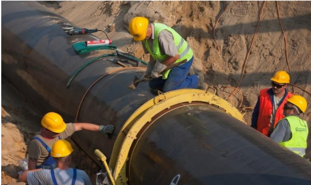
Abbildung 18: Verschweißen der Rohrabschnitte (Bsp.: Schweißarbeiten an einer Rohrleitung > DN 1200)
