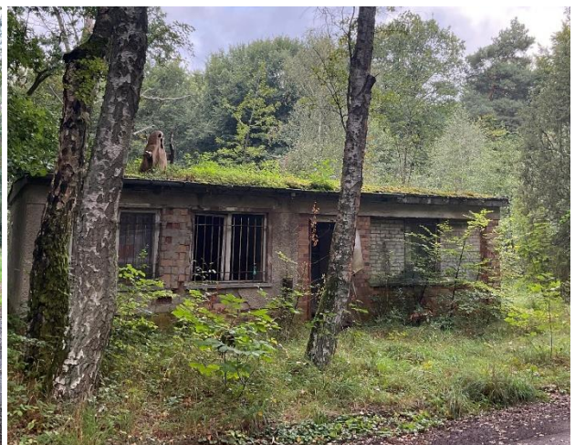
Abb. 33: sonstiges Bauwerk, Ruine (Biotop Nr. 100)
