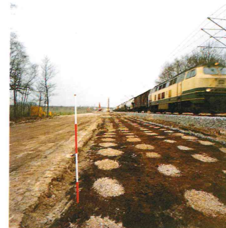
Aushubsohle nach Rüttelstopfverdichtung
