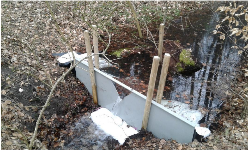
Abbildung 4-17: Messblende (MB 2) am Fließ zwischen Kunsterspring kurz nach dem Bau
