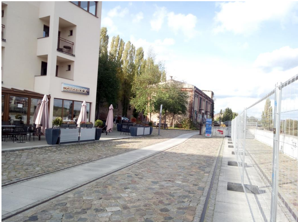
Abbildung 25: Baustellenausfahrt am Ende Abschnitt 1
