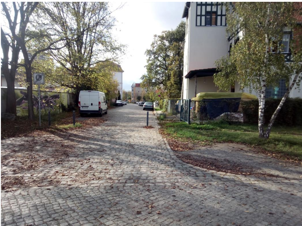
Abbildung 28: Baustellenausfahrt über Klingestraße
