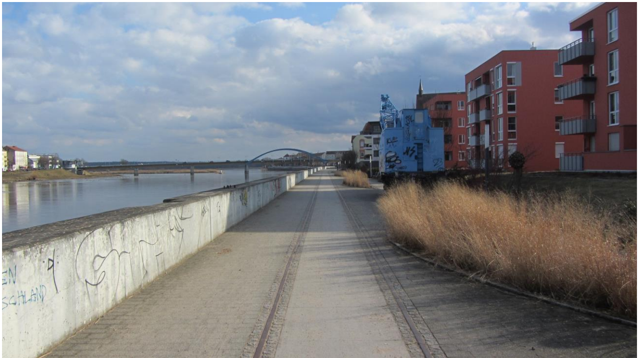
Abbildung 9: Freifläche zwischen Römertreppe und Ende der Baumaßnahm in Richtung Süden
