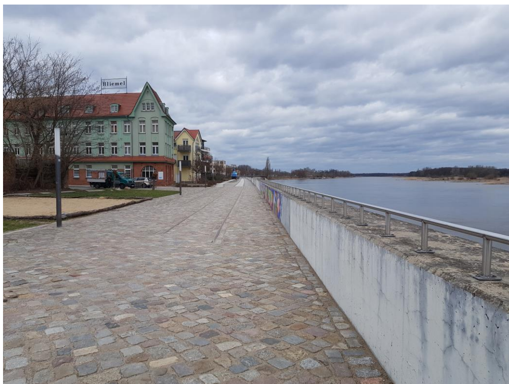
Abbildung 8: Freifläche zwischen Römertreppe und Ende der Baumaßnahme in Richtung Norden
