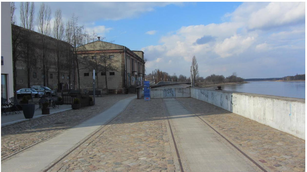
Abbildung 10: Ende der Baumaßnahme am Oder-km 584,70
