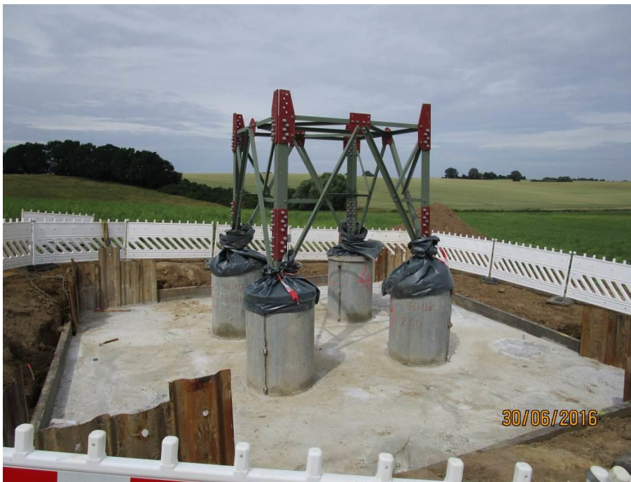
Abb. 10: Baugrube mit Fundament (Beispiel)
