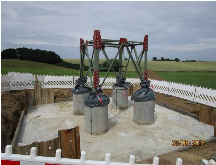
Abb. 10: Baugrube mit Fundament (Beispiel)
