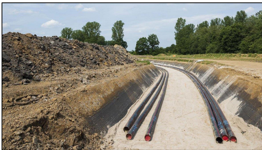
Abb. 9: Kabeltrasse mit Bettung und Schutzrohr (Beispiel)
