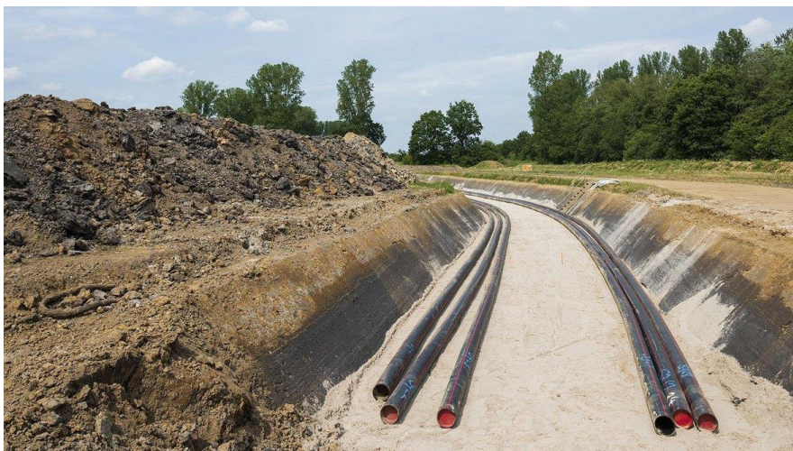
Abb. 9: Kabeltrasse mit Bettung und Schutzrohr (Beispiel)
