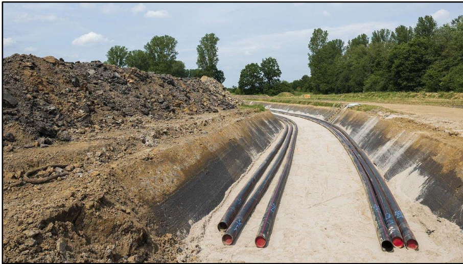
Abb. 9: Kabeltrasse mit Bettung und Schutzrohr (Beispiel)
