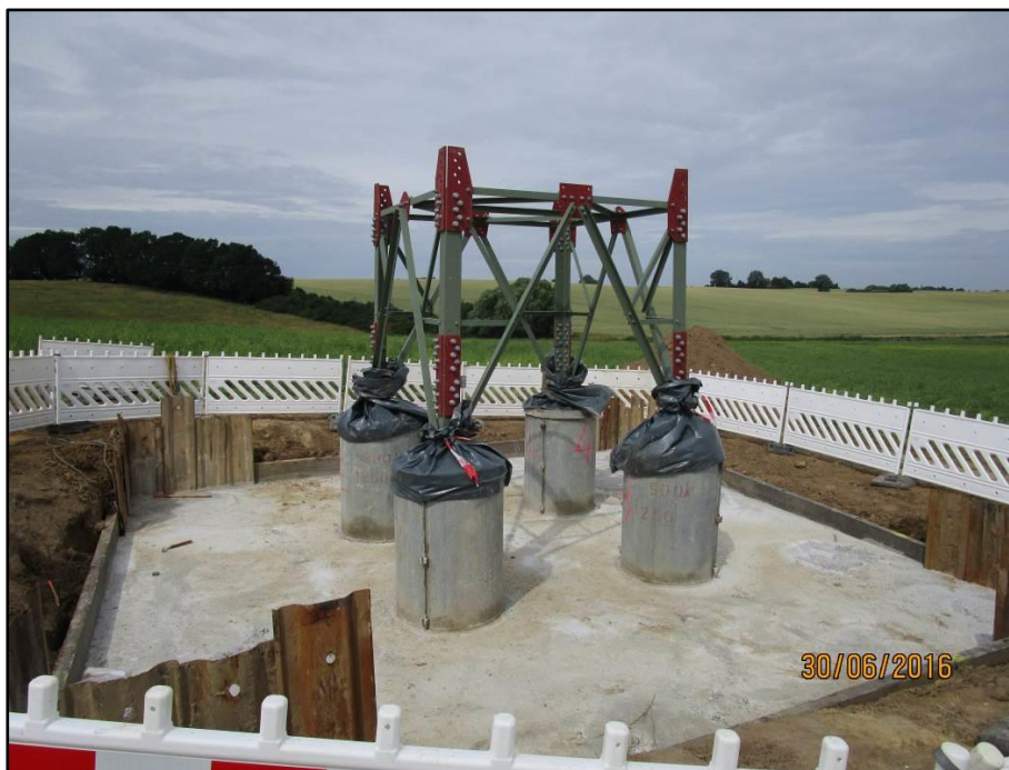
Abb. 10: Baugrube mit Fundament (Beispiel)
