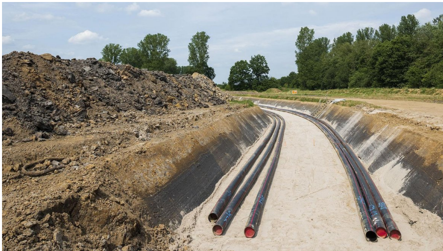
Abb. 30 - Kabeltrasse mit Bettung und Schutzrohr (Beispiel)
