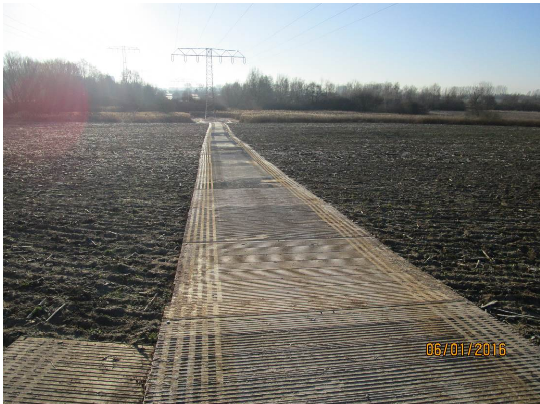
Abb. 29 - Beispiel einer Baustraße mit Matten (Beispiel)
