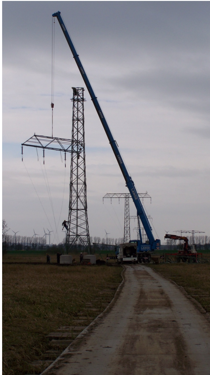
Abb. 32 - Maststellen mittels Autokran (Beispiel)
