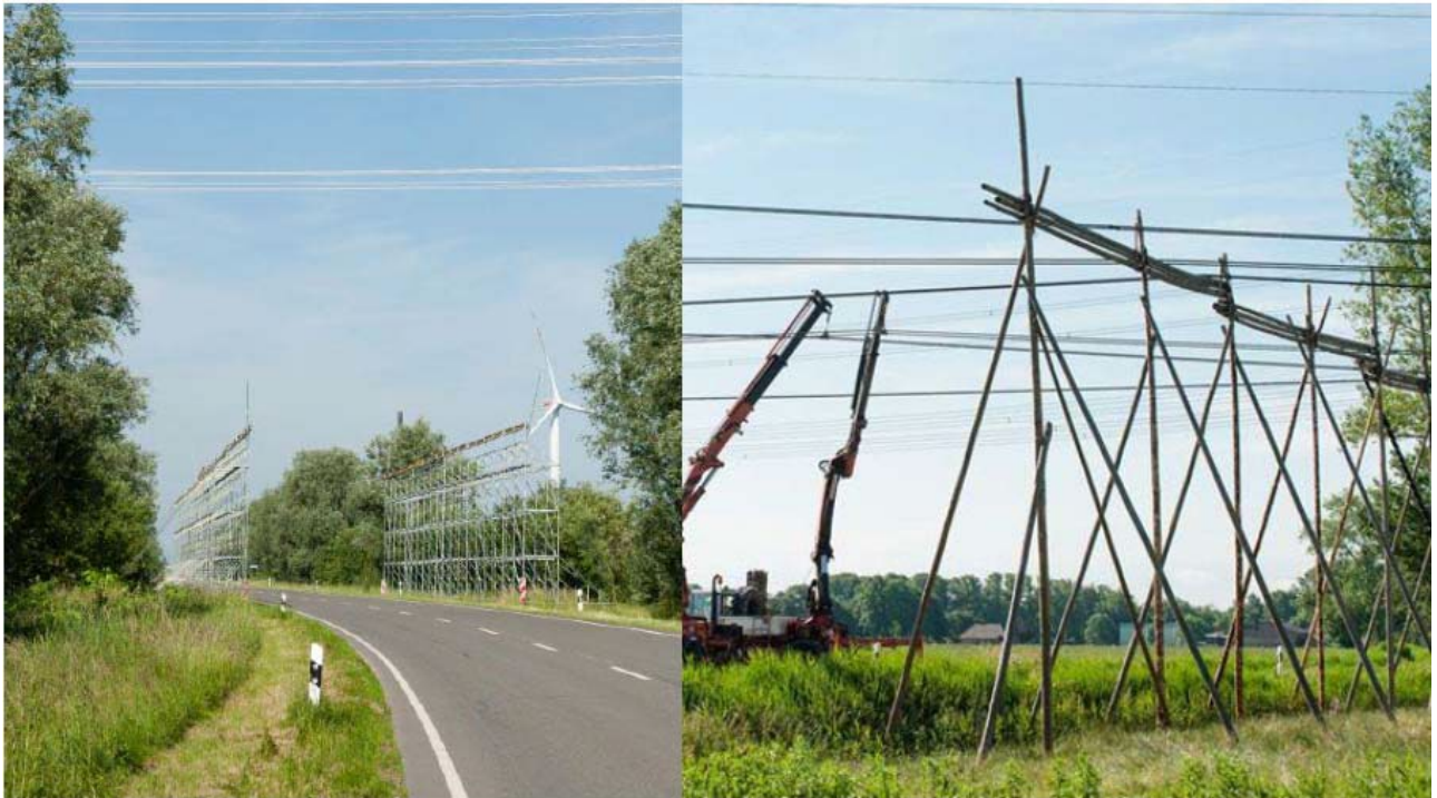
Abb. 35 - Beispiele für Schutzgerüste aus Stahl bzw. Holz
