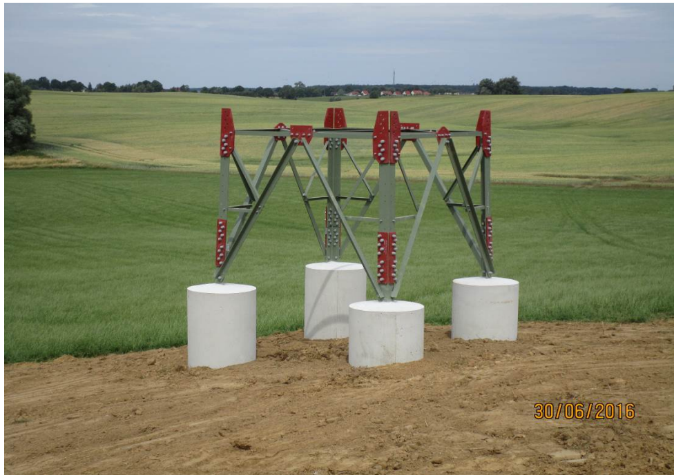
Abb. 27 - Beispiel eines wiederverfüllten Plattenfundamentes (Beispiel)
