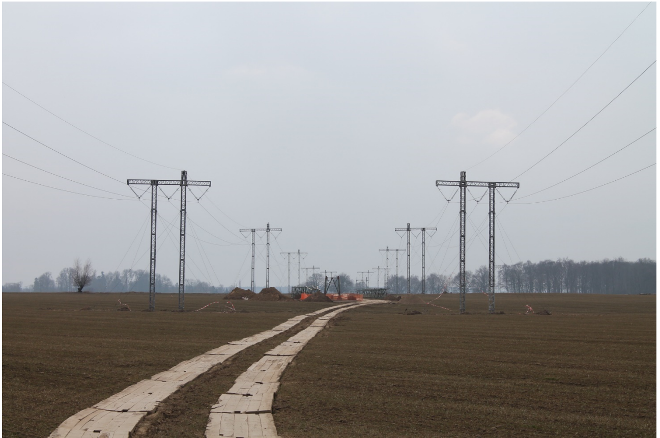
Abb. 34 - Freileitungsprovisorien (Beispiel)
