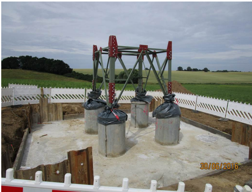
Abb. 31 - Baugrube mit Fundament (Beispiel)
