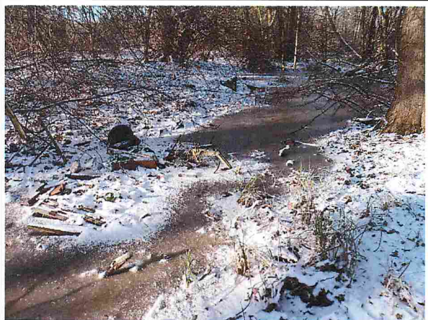
Ansicht der Absperrung des Altarmes 5a durch das Deponiegut, welches schon zum Teil durch das Wasser des Winterstaus überflutet wird.
