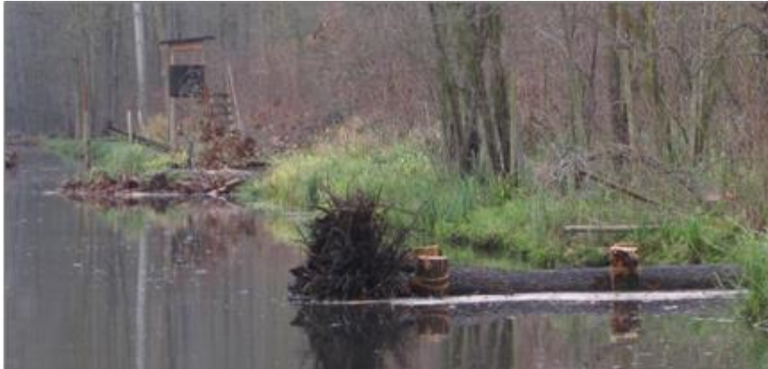
Abbildung 4.12: Beispiel für einen ufernahen Totholzeinbau (Foto: IHC)
