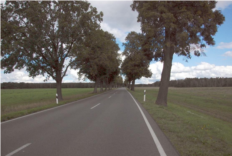
Abbildung 10: Allee an der L55 nördlich von Bronkow
