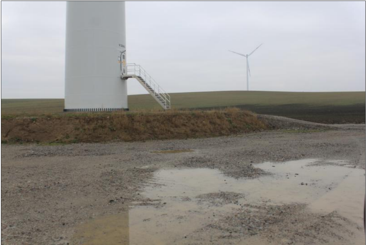
Abb. 9: bestehende WEA mit Böschungsanschlüttung am Fundament sowie vorgelagerter Kranstellfläche aus Schotter
