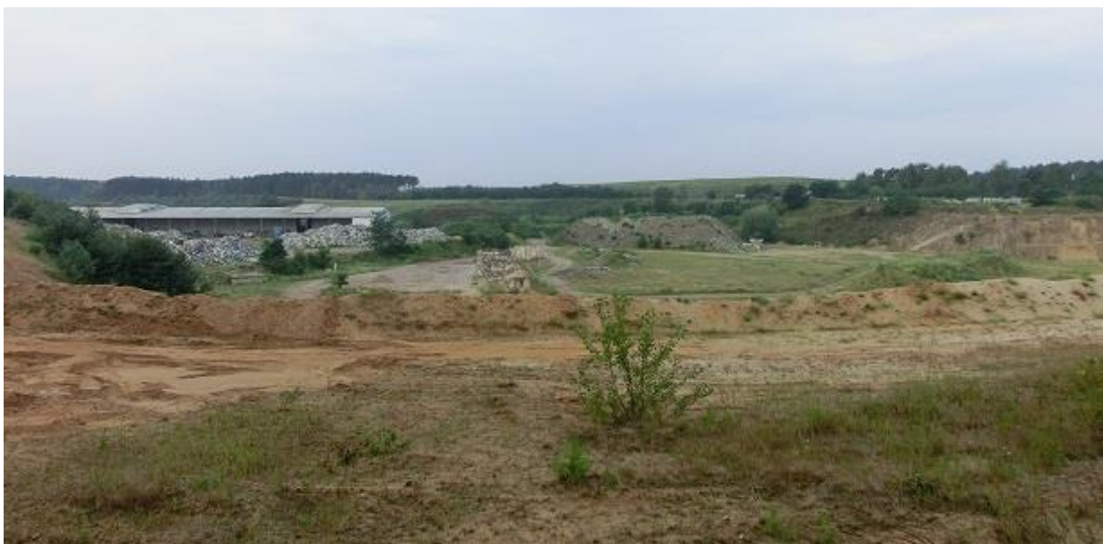
Abb. 2: Kiessandtagebau Fresdorfer Heide mit Brech- und Sortieranlage sowie im Hintergrund abgedeckte Deponiefläche der STEP GmbH Potsdam
