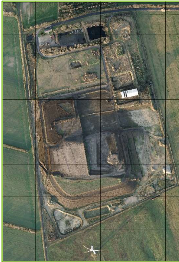
Abb. 2: Luftbild der Sonderabfalldeponie Röthehof [Quelle: MEAB Befliegung Januar 2023]
