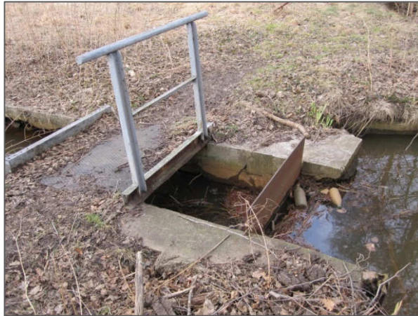
Abb. 2 Grabenabzweig zu Dubteichen am Wehr 17.33
