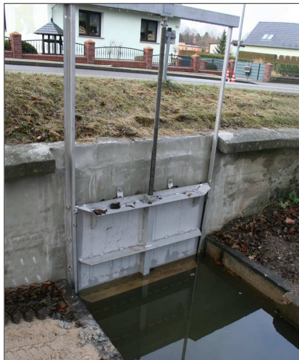
Abb. 3 Neuer Absperrschieber vom Dez. 2016
