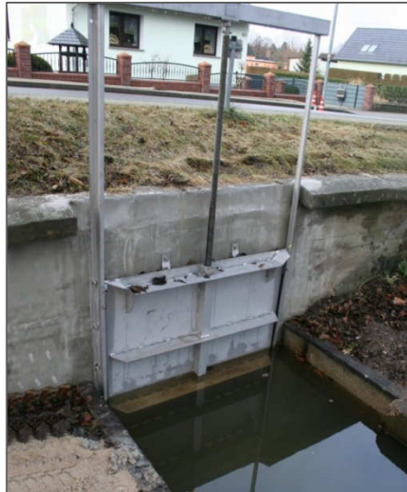
Abb. 3 Spindelschieber Notverschluss
