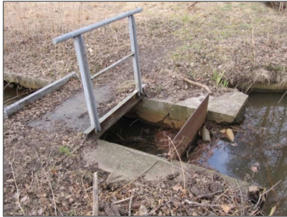
Abb. 2 Grabenabzweig zu Dubteichen am Wehr 17.33
