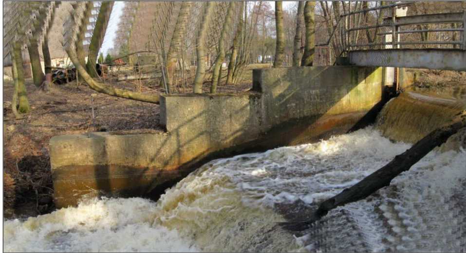
Abb. 3 Altwehr 17.33a mit Kaskadenboden
