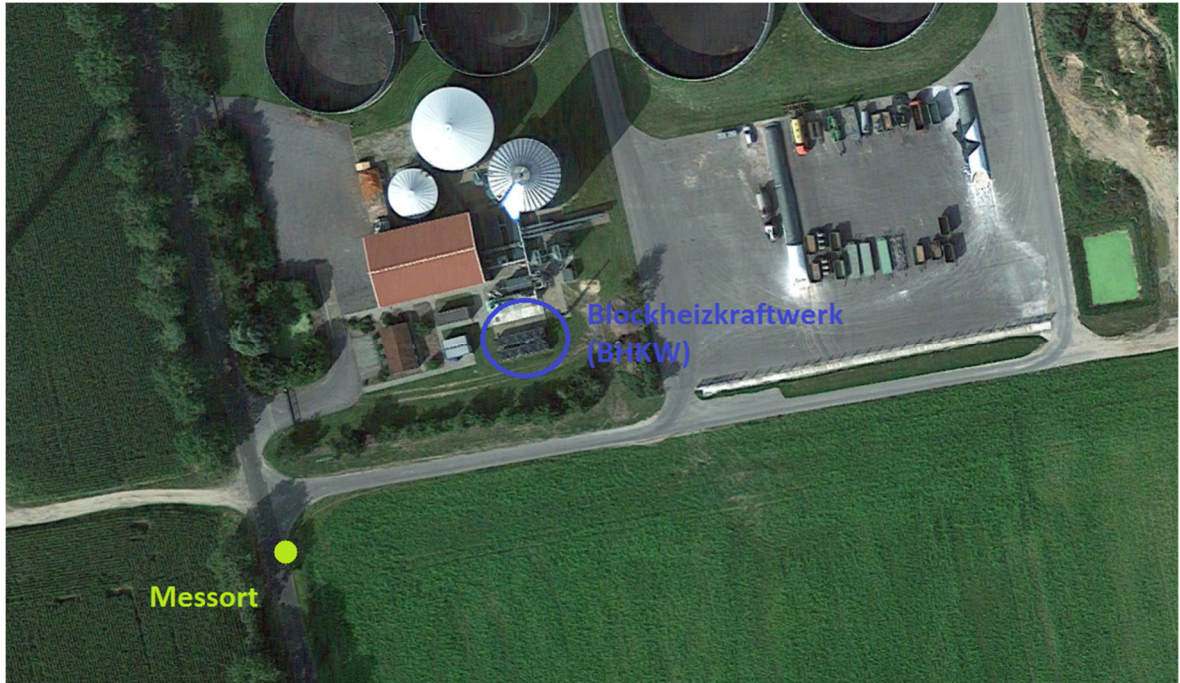
Abbildung 2: Luftbild mit Kennzeichnung des Blockheizkraftwerkes und Messortes (Quelle: https://www.google.de/maps/ , Stand: 09.06.2016)
