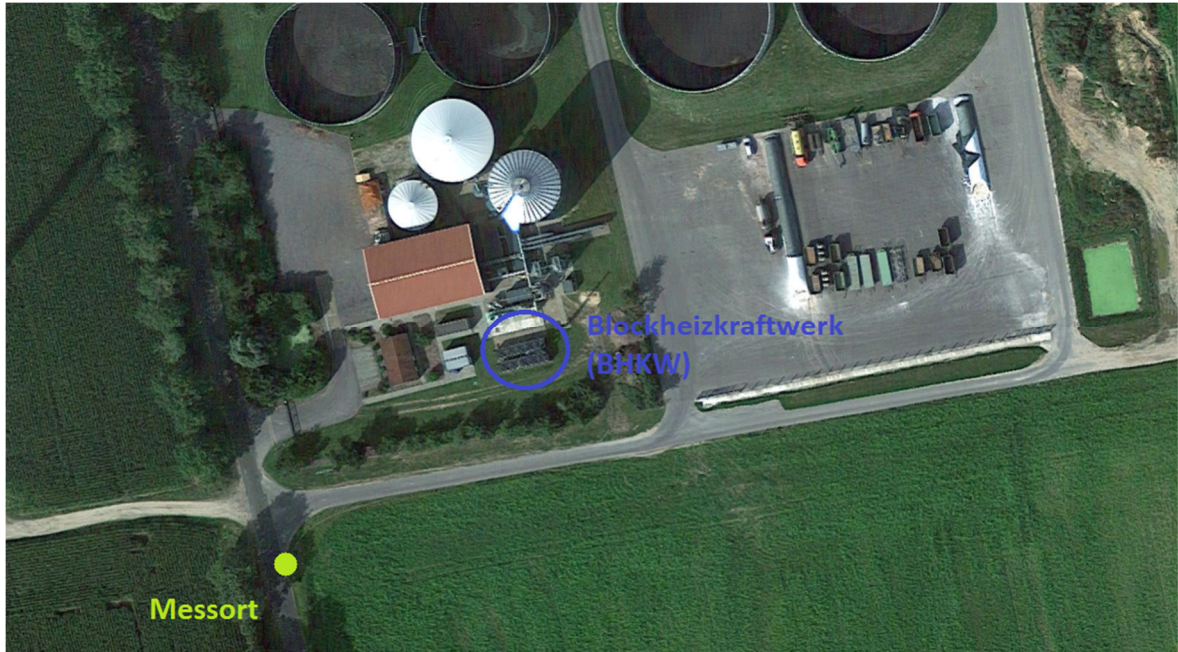
Abbildung 2: Luftbild mit Kennzeichnung des Blockheizkraftwerkes und Messortes (Quelle: https://www.google.de/maps/ , Stand: 09.06.2016)
