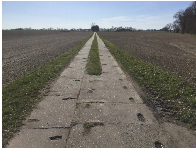
Abb. 3. Bereich der Abzweig der temp. Zuwegung zur WEA 2 u. a. sowie Standort und Nebenflächen WEA 1 (im Bild links des Plattenweges) (Foto 06.04.2018).
