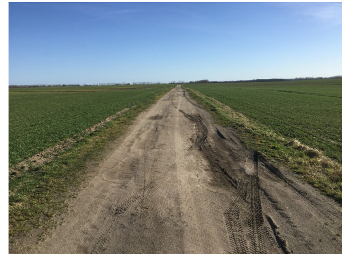
Abb. 25. Zuwegung zur WEA 9, 10 und 12 saumlosen, teilversiegeltem Weg, Blick nach Süden, links des Weges Standort WEA 13, rechts Zuwegung zur WEA 14 (Foto 06.04.2018).
