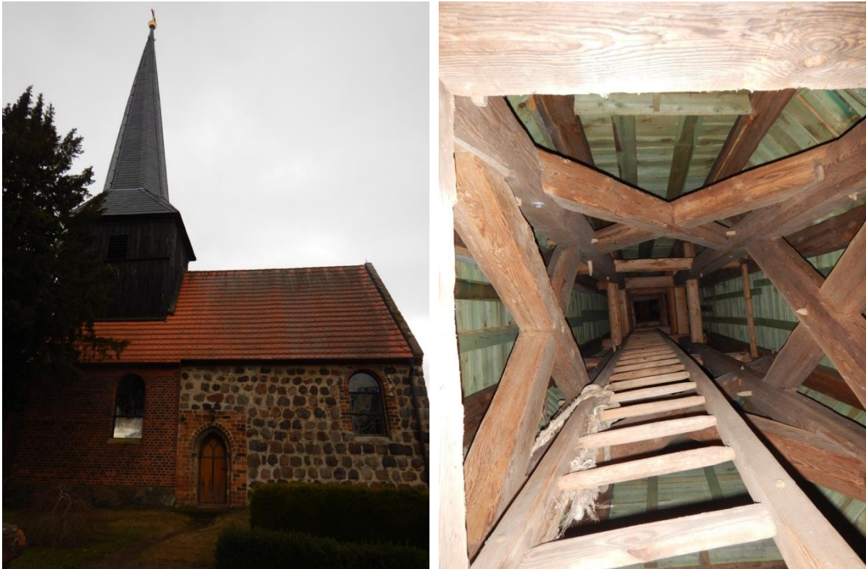
Abbildung 18: Kirche mit hohem Quartierpotential und Innenansicht Kirchturm in Küdow
