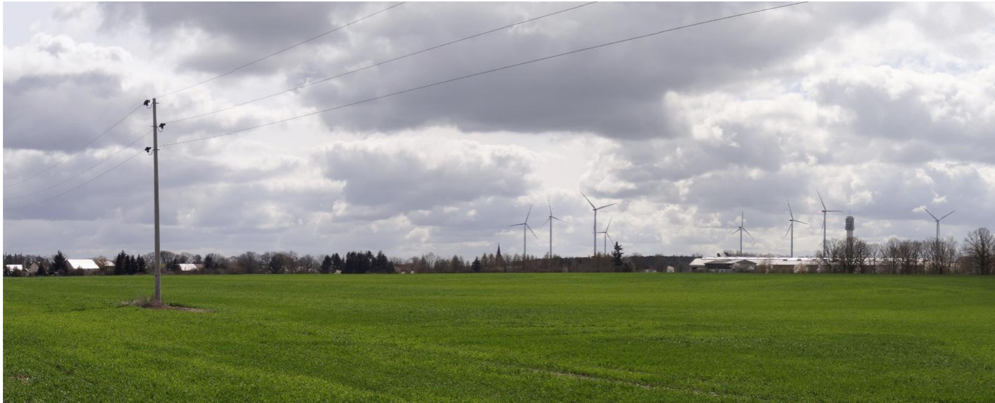
Abbildung 38: Fotopunkt 1, Blick von der Landstraße L70 (nordwestlich von Petkus) in südöstliche Richtung über die Ortschaft Petkus auf bestehenden Windpark
