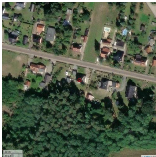
Abbildung 8.11: Satellitenansicht SR-11 (Bahnhofstraße 23; 15299 Mixdorf)
