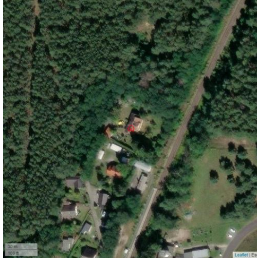
Abbildung 8.24: Satellitenansicht SR-24 (Am Bahnhof 2; 15299 Mixdorf)
