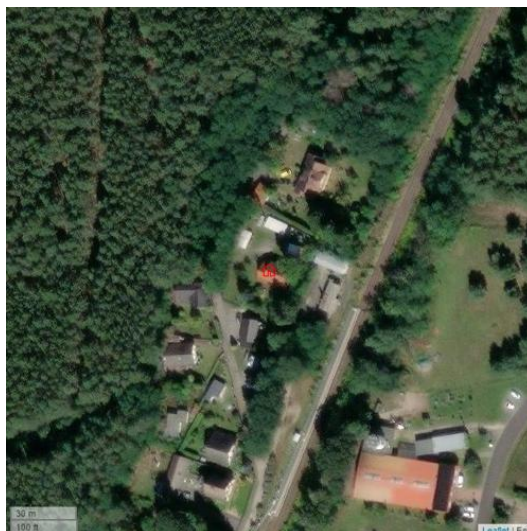
Abbildung 8.23: Satellitenansicht SR-23 (Am Bahnhof 3; 15299 Mixdorf)
