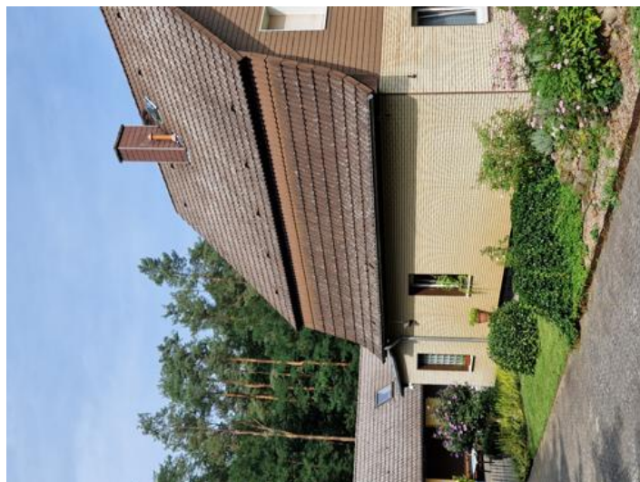
Abbildung 9.3: Südansicht IO-03 (Am Bahnhof 4; 15299 Mixdorf)
