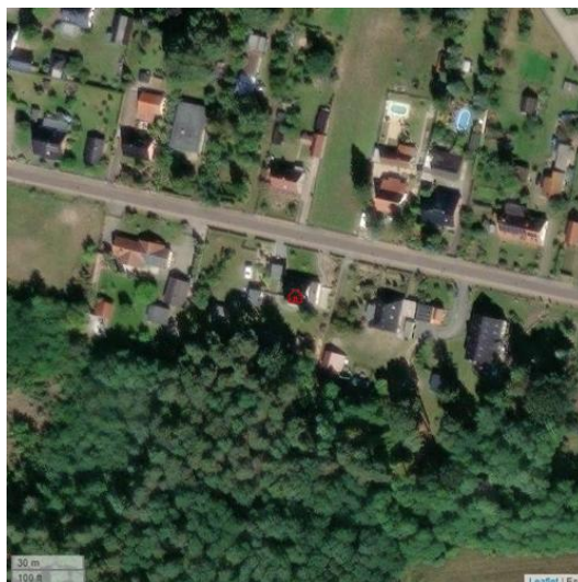
Abbildung 8.11: Satellitenansicht SR-11 (Bahnhofstraße 23; 15299 Mixdorf)
