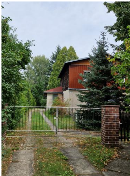
Abbildung 9.1: Süd-Westansicht IO-01 (Am Bahnhof 14; 15299 Grunow-Dammendorf)
