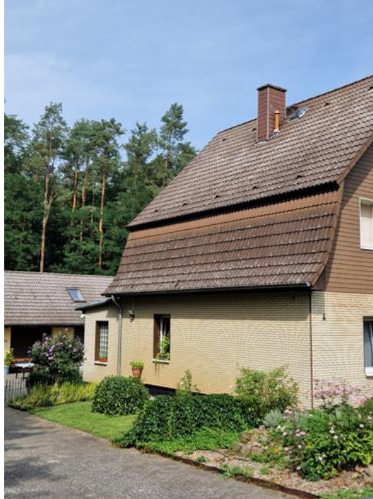
Abbildung 9.3: Südansicht IO-03 (Am Bahnhof 4; 15299 Mixdorf)
