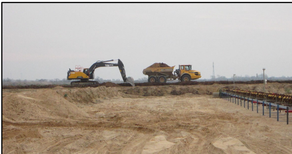
Abbildung 78: Abraumräumung mittels Hydraulikbagger und Dumper
