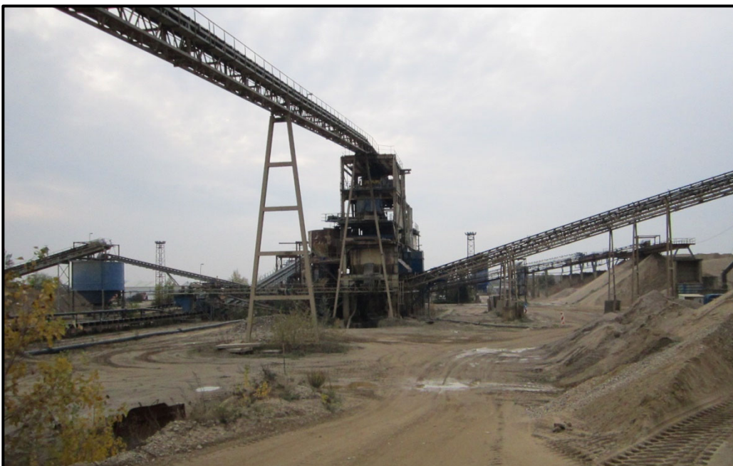
Abbildung 910: Aufbereitungskomplex Werk II
