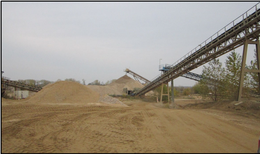
Abbildung 4011: Rohkiesfreilager mit Unterflurabzug
