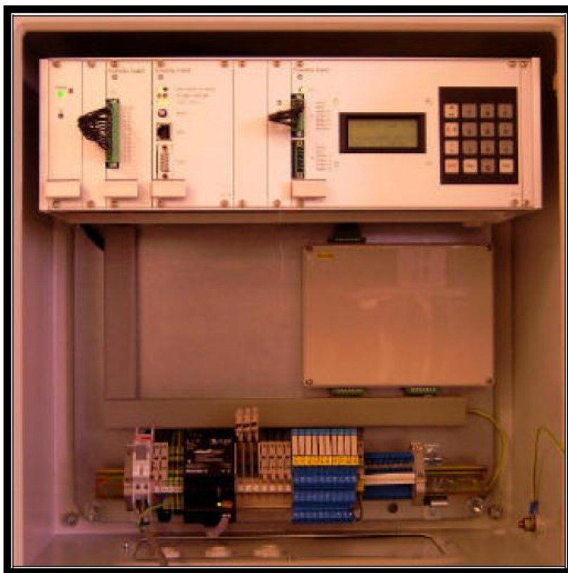
Abbildung 10-2: Schattenwurfmodul Innenansicht
