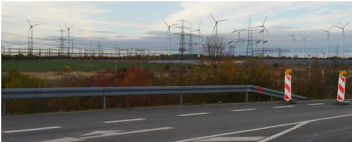
Abb. 43: Umspannwerk Wustermark und angrenzende Freileitungen im Bereich der Vorhabenfläche.
