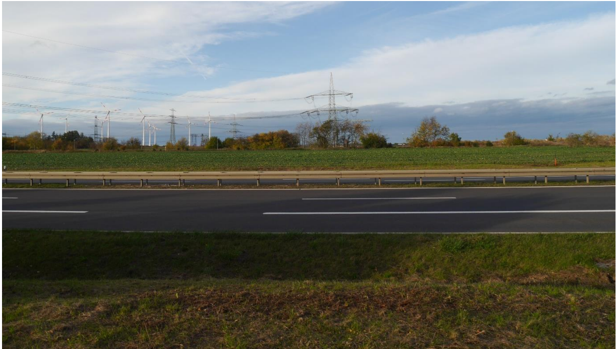
Abb. 48: Blick vom Ortsrand der Ortslage Wustermark von der Straße „An der Ziegelei“ ausgehend auf die Vorhabenfläche mit den Hochspannungsleitungen. Das Rechenzentrum wird sich in das Landschaftsbild einfügen.
