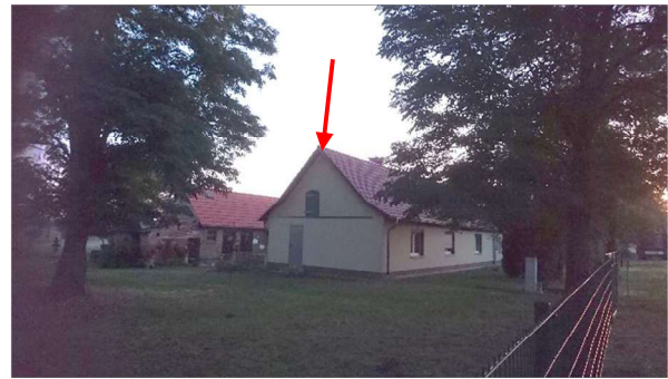
Abbildung 26: Nr.3, Giebelbereich eines Wohngebäudes
