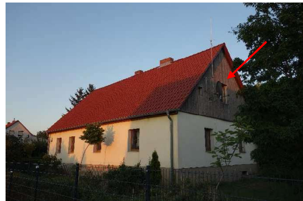
Abbildung 24: Nr.2, Wochenstubenquartier der Zwergfledermaus hinter Holzverschalung des Gebäudes
