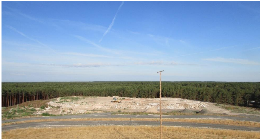
Abbildung 1: Restablagerungsbereich Schüttbereich II Deponie Forst-Autobahn
