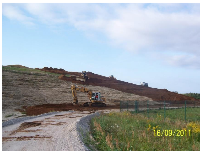
Abbildung 6: Herstellung der Trag- und Ausgleichsschicht mit Baggergut Deponie Spremberg 2011
