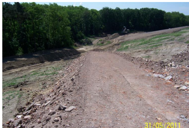
Abbildung 5: Bau Auffahrt mit Gemischen aus Beton, Ziegel, Fliesen und Keramik auf der Deponie Spremberg-Cantdorf
