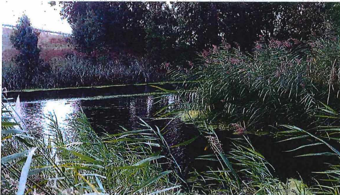
Abbildung 7: DEBB582868_824 - Zülowkanal (rechts) mündet in den Nottekanal (links)
