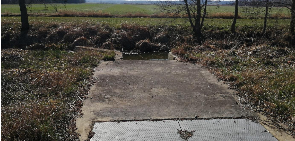
Abbildung 7 Zulaufstelle der ehemaligen Kläranlage Pramsdorf in den Zülowkanal
