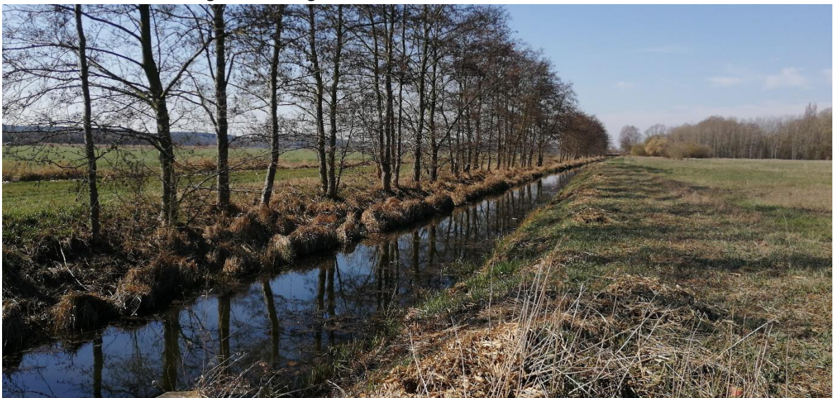
Abbildung 9 Blick auf den Zülowkanal in Richtung Rangsdorfer See
