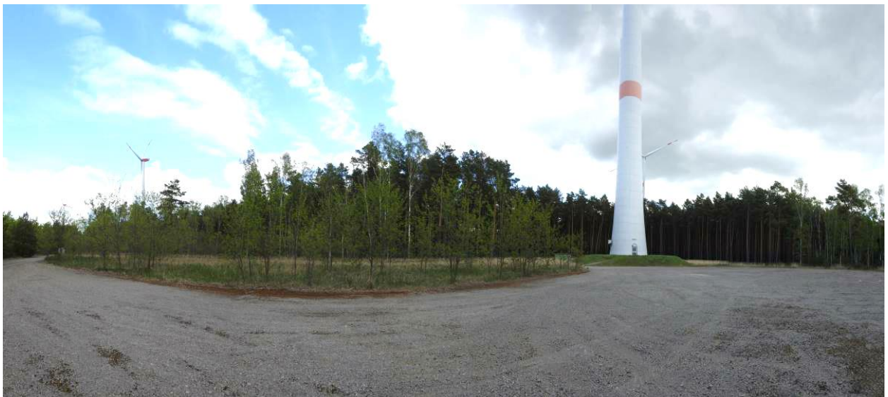
Abbildung 25: bestehende WEA im Wald des östlichen Nahbereichs der zwei geplanten WEA
