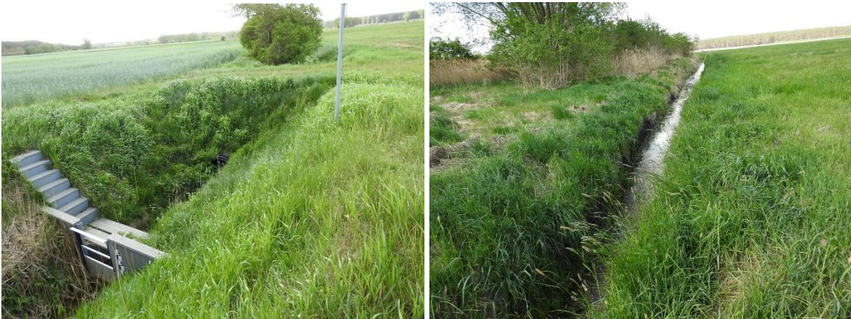
Abbildung 5: Samgasefließ mit Stauschieber zur Regulierung des Wasserhaushalts im Moor
